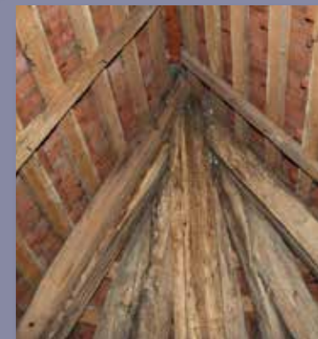
Undichte Stellen und Holzwurmbefall müssen dringend beseitigt werden
