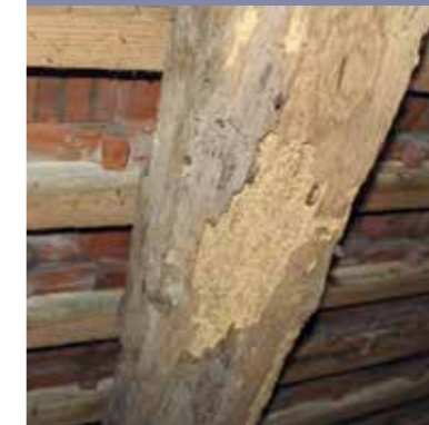
Undichte Stellen und Holzwurmbefall müssen dringend beseitigt werden
